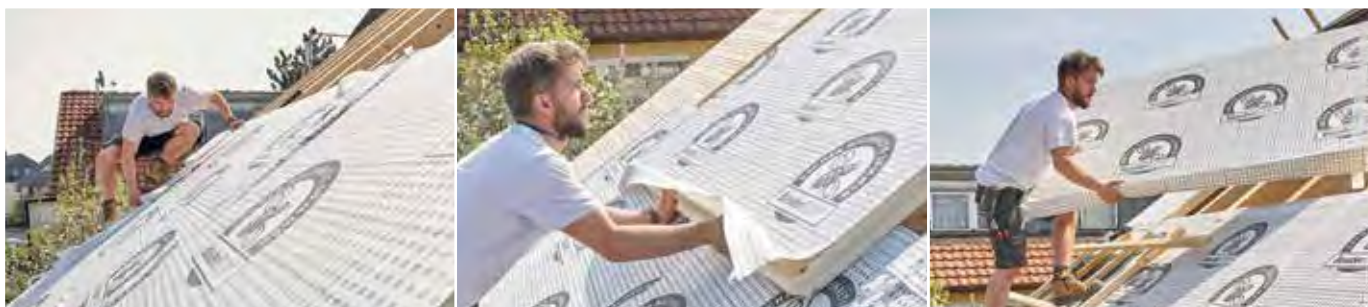
Verlegung von BauderECO als Aufsparrendämmung
