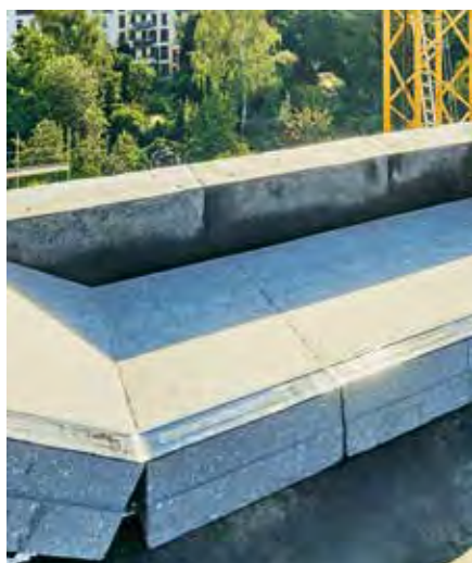
Icopal Sicherheitsdämmbahn: das praktische „2-in-1-System“ auf der Baustelle
