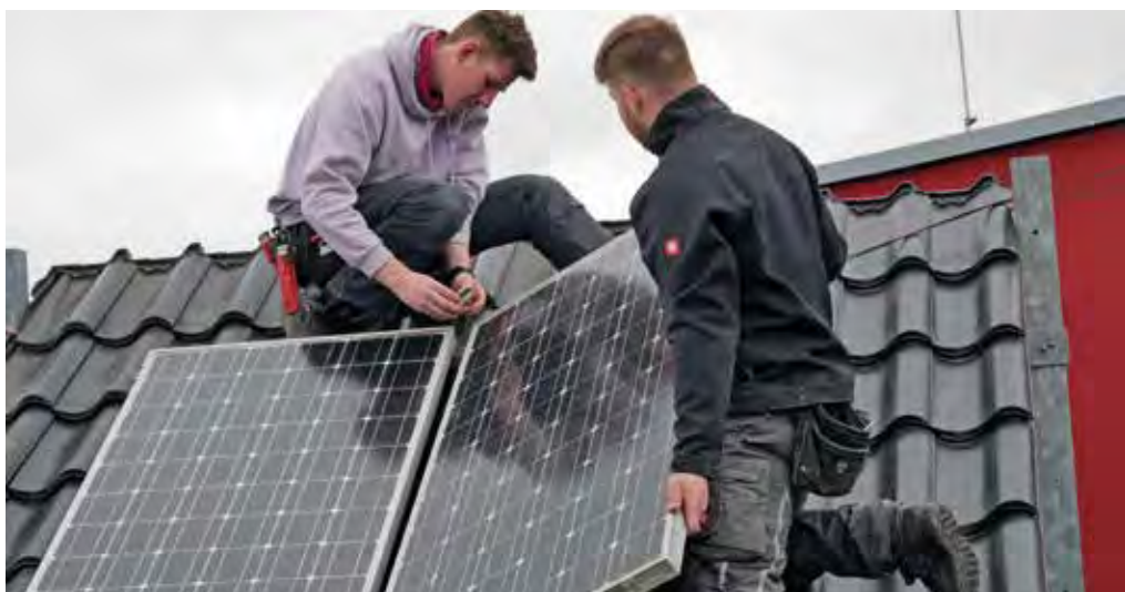
Eslohe – Arbeiten an einer PV-Anlage
